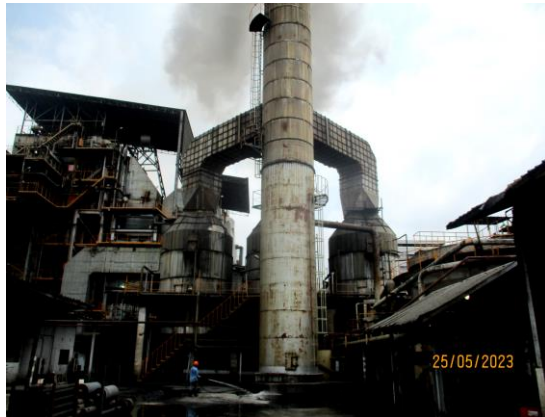
รูปที่ 1 ระบบบำบัดฝุ่นละออง (Wet Scrubber)
