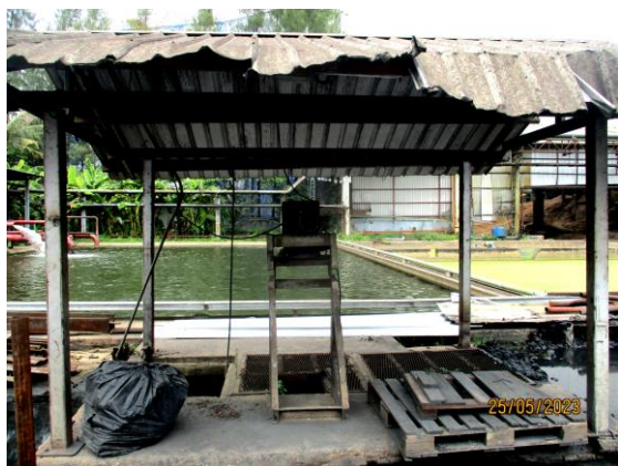
รูปที่ 13 ระบบถังแยกน้ำและน้ำมัน ( Oil Separator)
