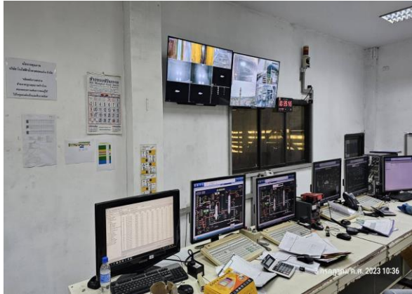
รูปที่ 7 ห้องควบคุมระบบสายพานลำเลียง
